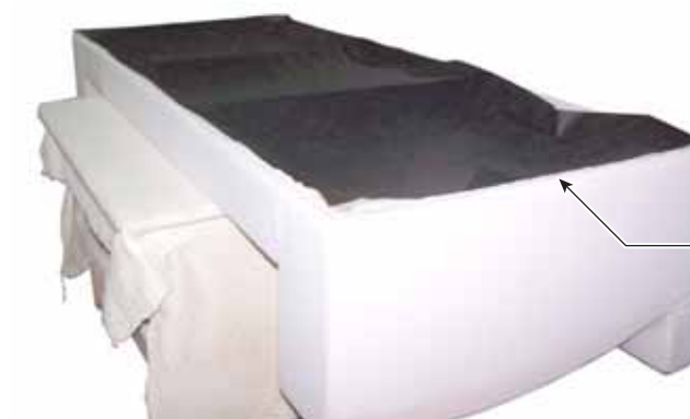
Figure 3.3.9 Pose de la toile de protection
