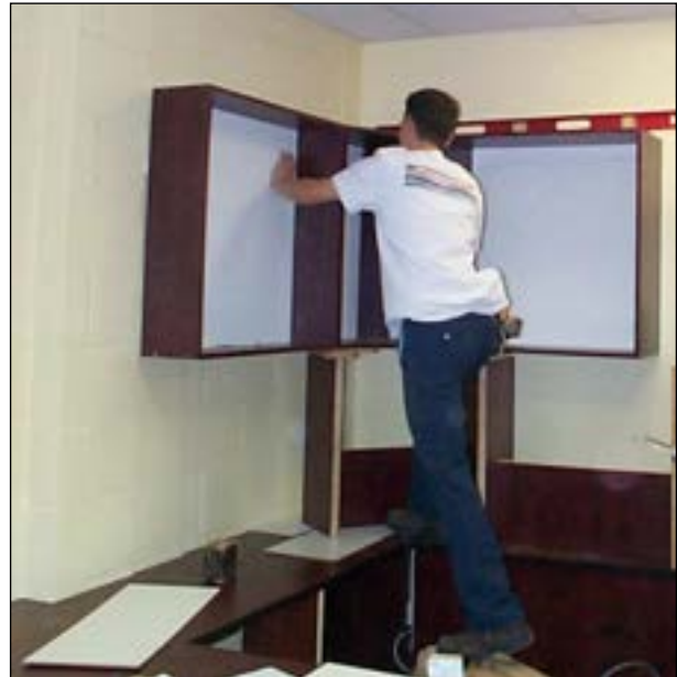
Figure C5.2.4 Fixation d'armoires sur un mur en maçonnerie
