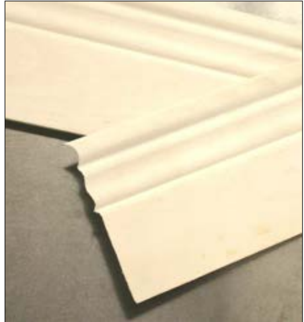
Figure C5.2.18 Joint profilé sur une plinthe
