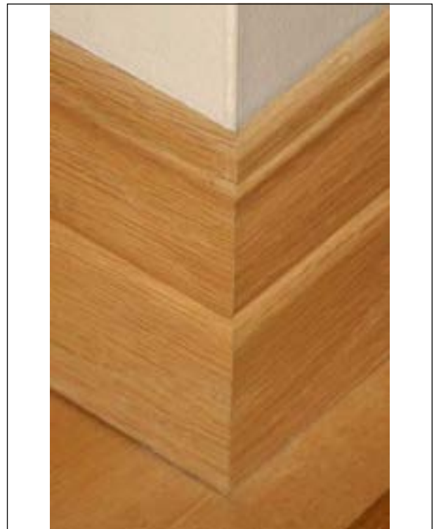
Figure C5.2.19 Plinthe sur une angle de mur sortant
