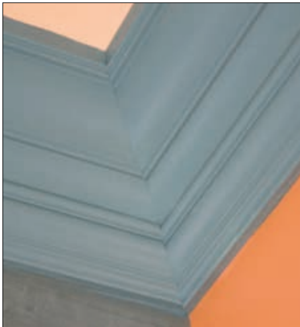
Figure C5.2.20 Exemple d'assemblage de moulures de corniche
