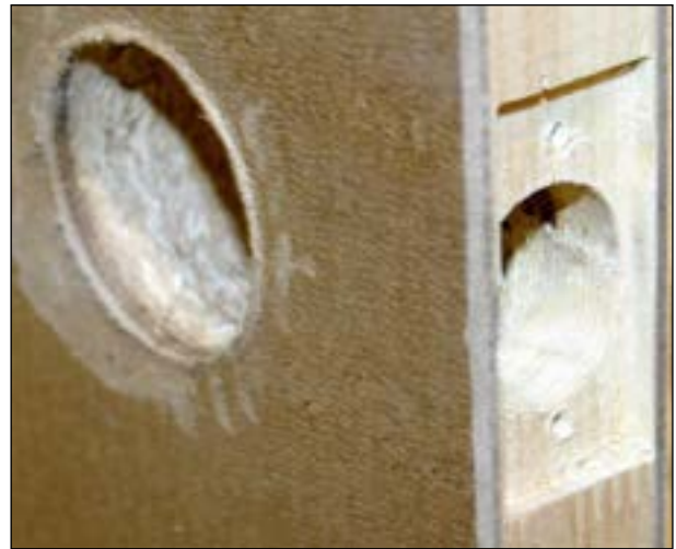
Figure C5.1.29 Trous percés pour la serrure et la poignée
