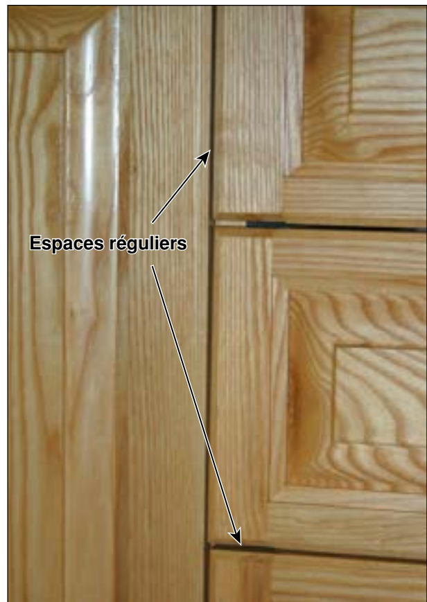
Figure C5.3.1 Espace régulier autour des éléments mobiles
