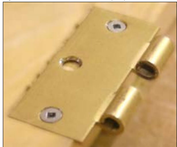
Figure C5.1.27 Incrustation d'une plaque de charnière
