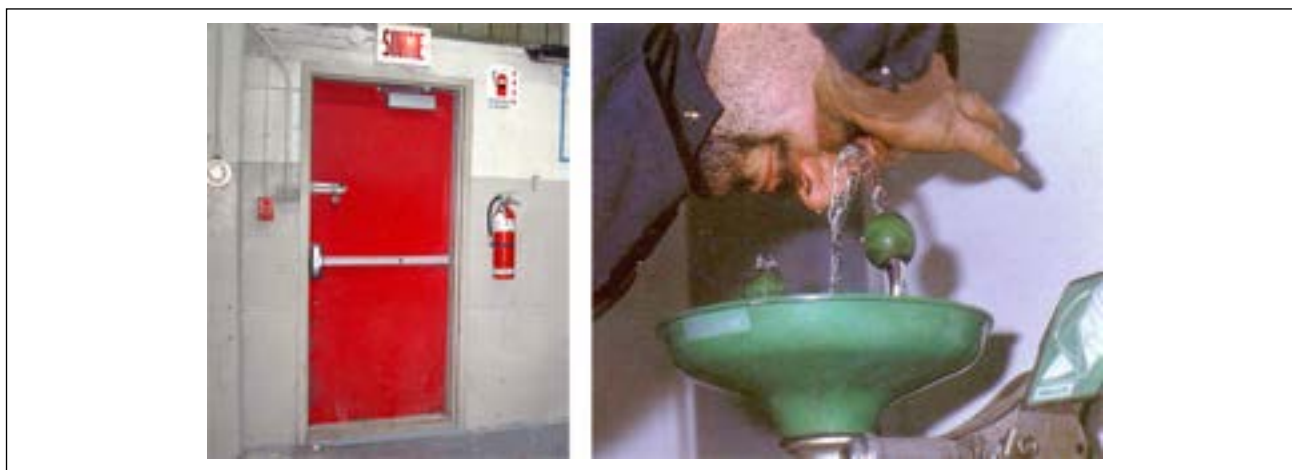
Figure 1.6.11 Accessibilité des dispositifs de sécurité (Auto prévention)
