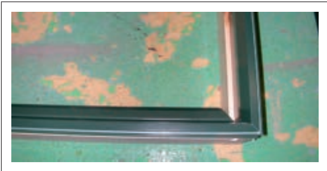
Figure C9.3.11 Taillage des extrémités des moulures
