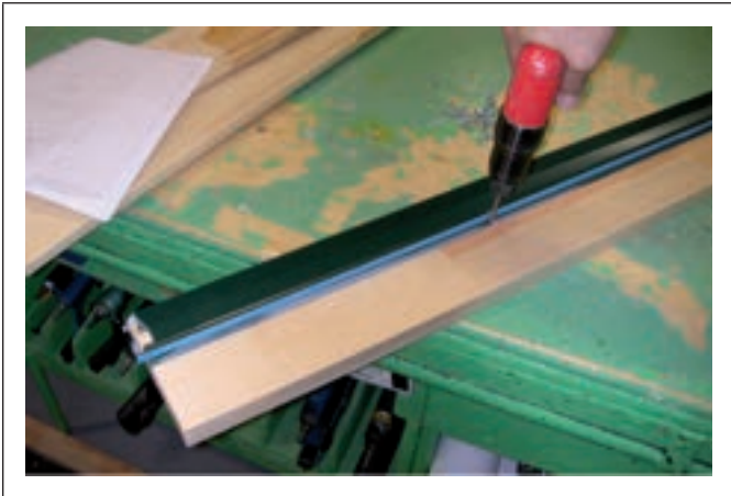
Figure C9.3.7 Fixation temporaire de la moulure
