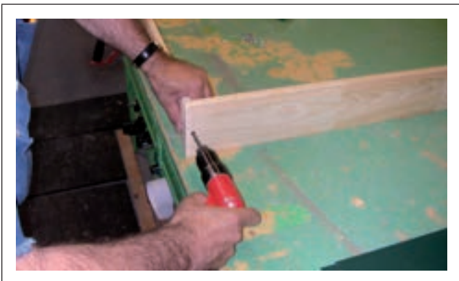
Figure C9.3.8 Fixation temporaire du côté et de la base
