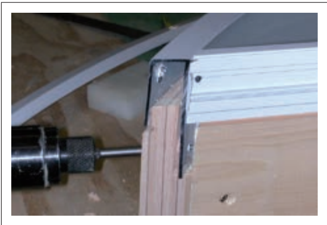
Figure C9.3.49 Application du scellant autour du cadre
