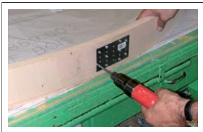
Figure C9.3.35 Pose d'une plaque de renfort
