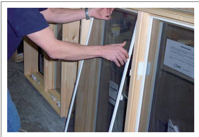
Figure 6.4.21 Pose de la moustiquaire
