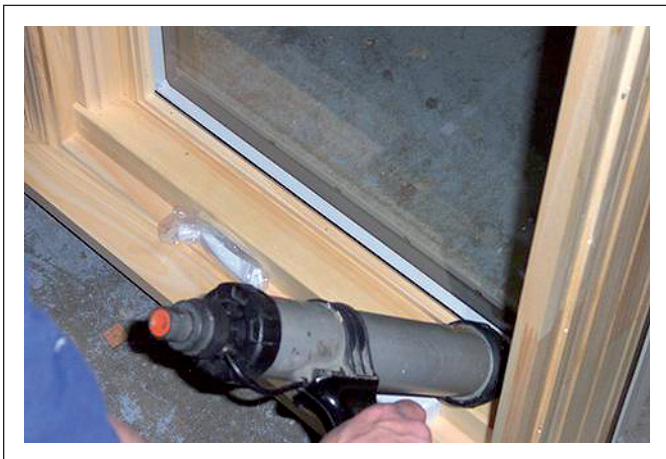
Figure 6.4.7 Pose du calfeutrage
