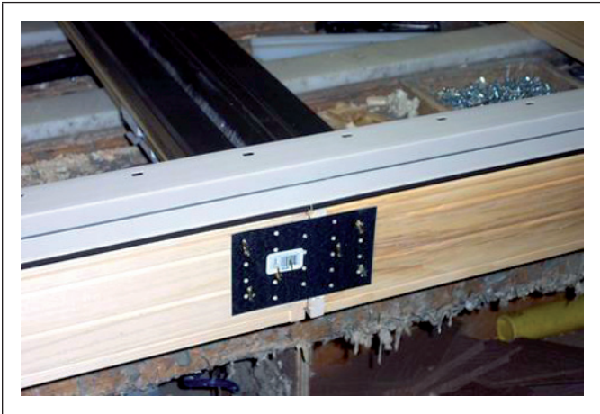
Figure 6.4.12 Pose d'un renfort d'acier
