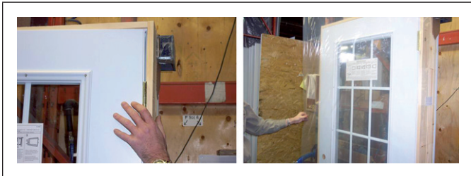
Figure 6.4.7 Pose du calfeutrage
