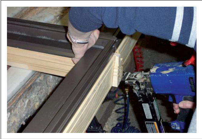
Figure 6.4.12 Pose d'un renfort d'acier
