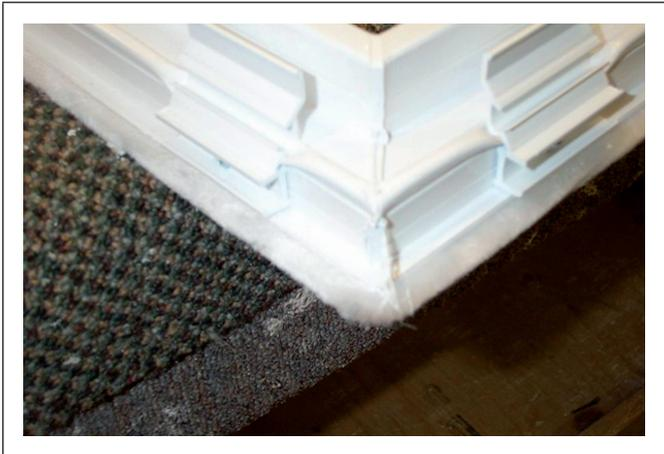
7. Installer les attaches de retenue si c'est un volet fixe. L'attache de retenue doit être enfoncée de façon que le coupe-froid soit bien inséré dans l'attache, puis visser.
