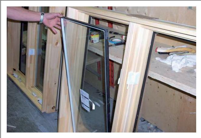
6. Insérer le vitrage dans le volet (utiliser les poignées à ventouses pour les vitrages de grandes dimensions).
