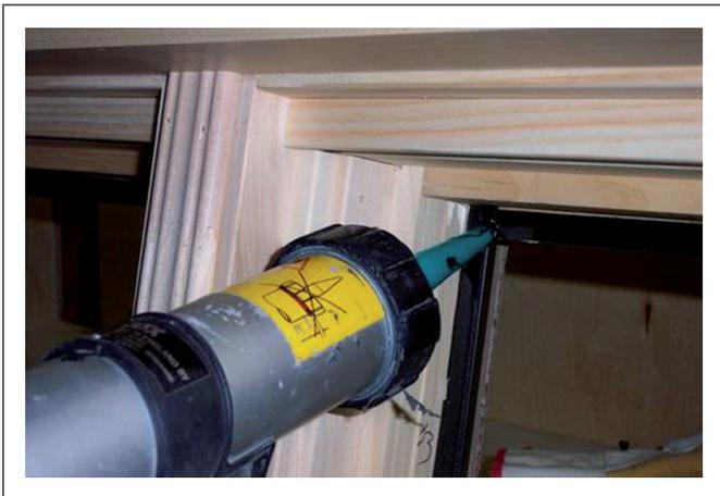
4. Appliquer du scellant dans les quatre coins, à la jonction des rubans de vitrage.
