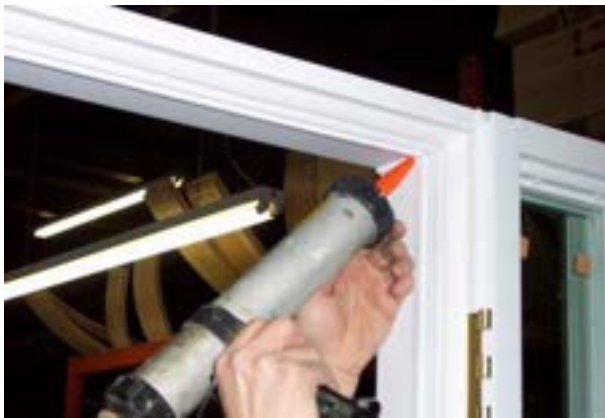
Figure 4.5.36 Scellement des recouvrements
