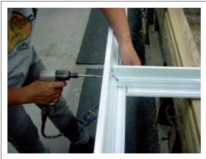
Figure 4.5.6 Vissage du meneau
