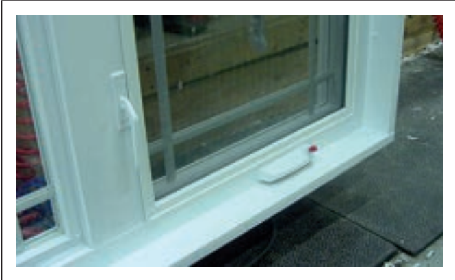
Figure 4.5.15 Pose du verrou
