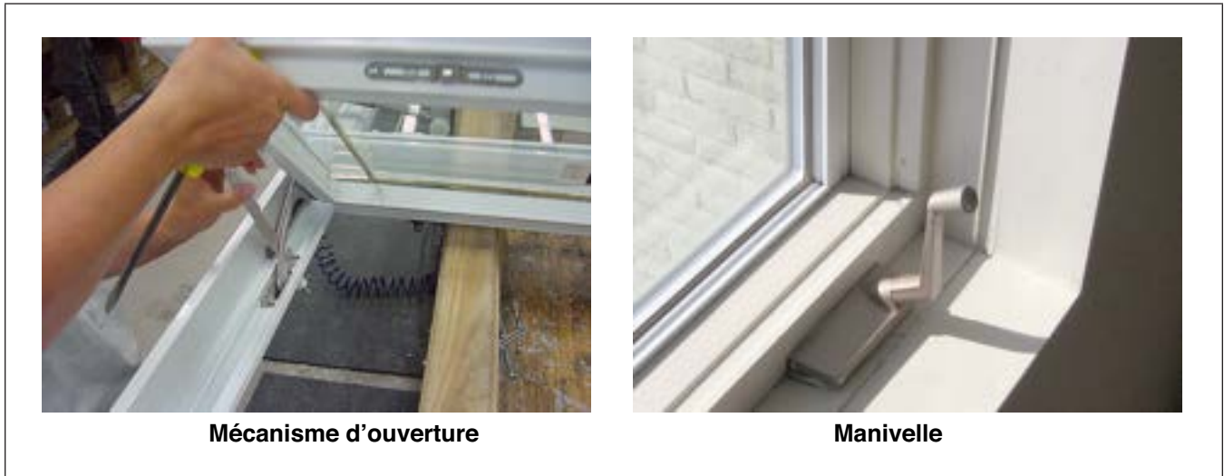
Figure 4.5.13 Mécanisme d'ouverture
