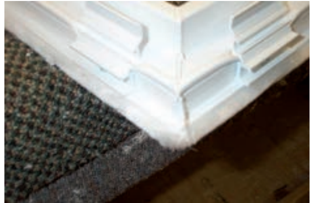
Figure 4.4.13 Soudure d'un profilé
