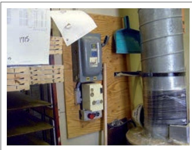
**Figure 1.2.10 Accessibilité des dispositifs de sécurité (Auto Prévention)**
