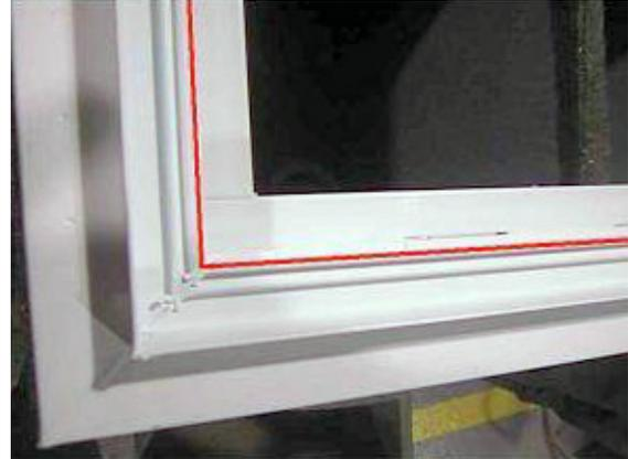
3. Positionner le cadre sur le module et fixer avec des broches tous les 200 mm (8 po).
